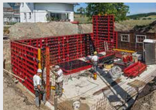
Cofraje pentru pereți
