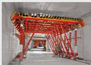
Cofraje pentru tunele
