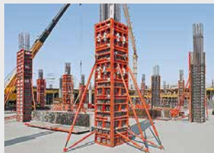
Cofraje pentru stâlpi
