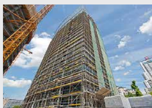
Schele – lucrări fațade
